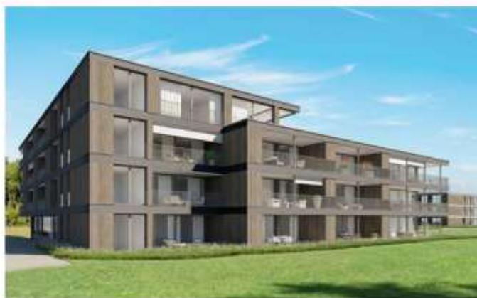
In der Überbauung «am Dorfbach» wird die erste Kappeler Kita einziehen
